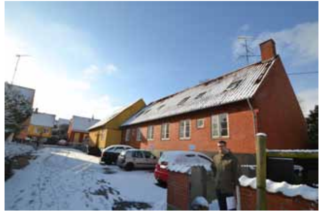
I denne bygning mod Glastorvet ligger også afdelings ejendoms kontor.
