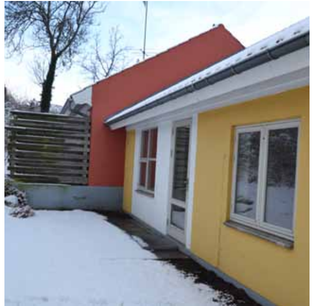
Havesiden med de små private terrasser.
