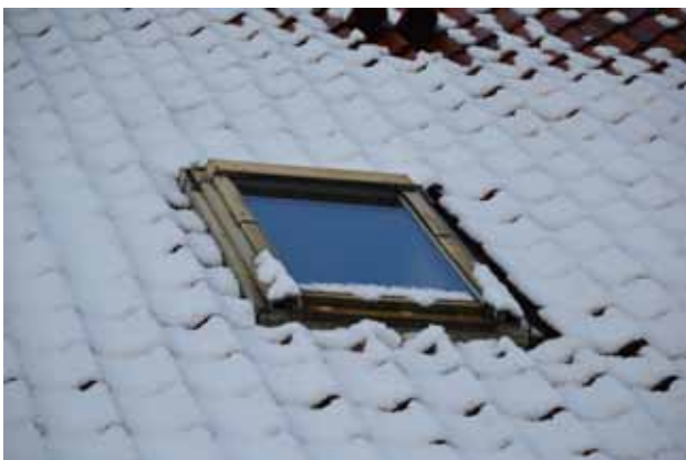
Ovenlysvinduerne er nedslidte og bør skiftes.
