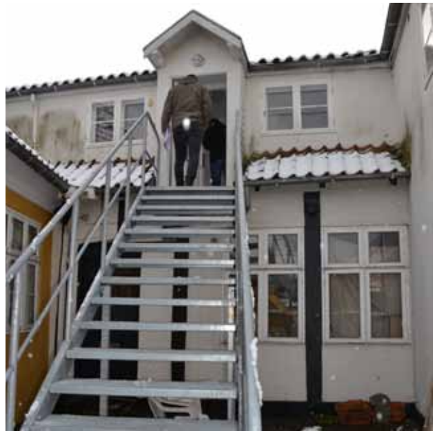
Til boligerne i tagetagen er der etableret en ståltrappe på gårdsiden.
