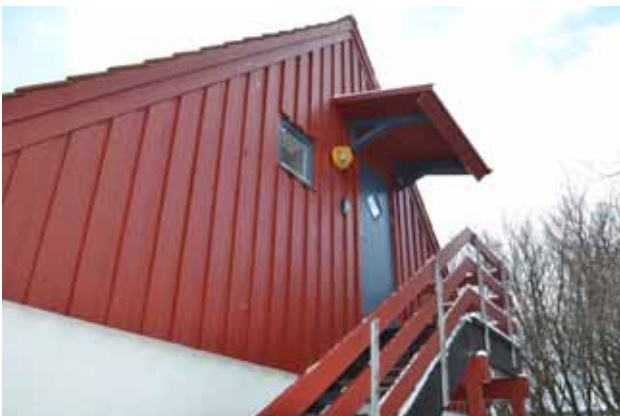
Der er adgang til boligerne på 1. sal ad en udvendig trappe.
