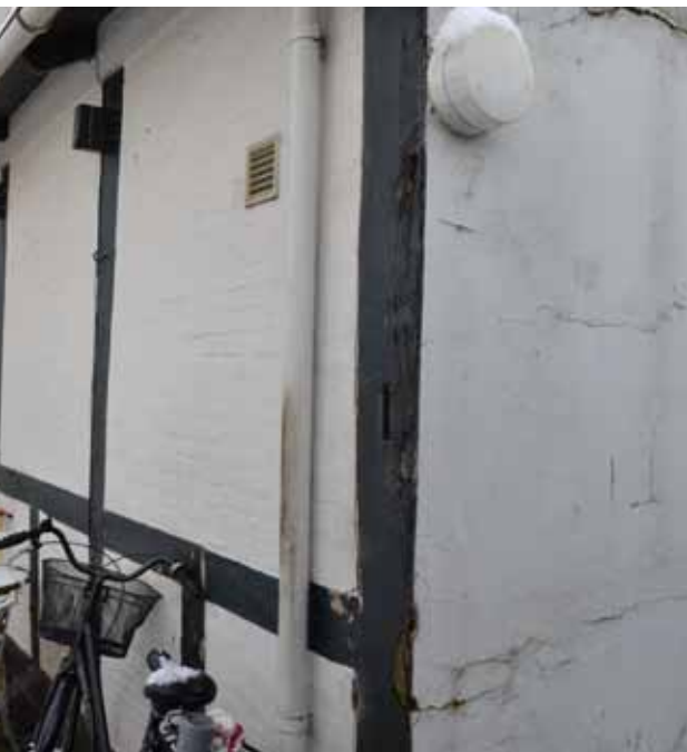
Facader og bindingsværk er præget af skader.
