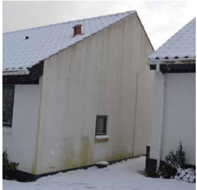
Der er misfarvninger på bygningernes gavle.
